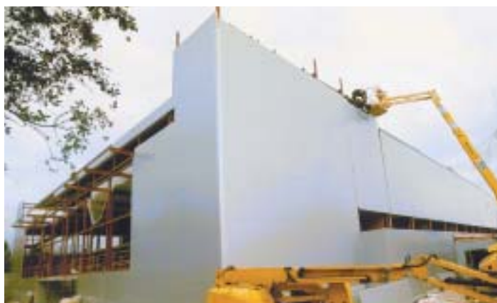
Las obras del nuevo pabellón están muy avanzadas
